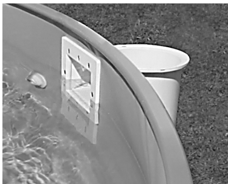
Zdj. 1 - skimmer zamontowany w ścianie asenu
